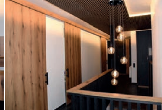
Die Zugänge zu den Räumlichkeiten sind mit raumhohen Schiebetüren ausgeführt.
